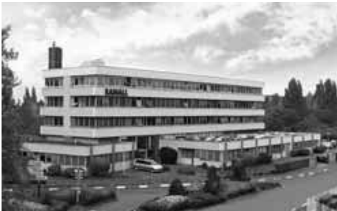
Head Office - Rosny sous Bois
